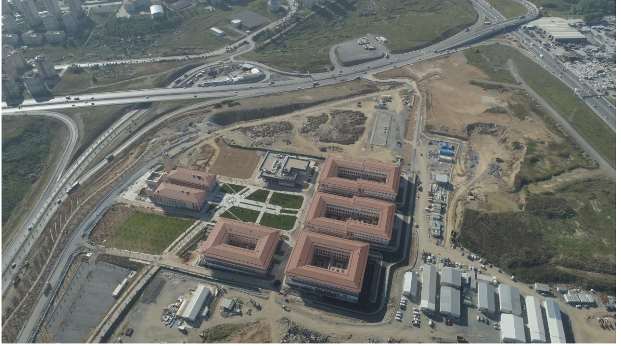
Külliye Genel Görünümü (Rektörlük, İnsan ve Toplum Bilimleri Fakültesi, Yönetim Bilimleri Fakültesi, Diller Okulu, Öğrenci Merkezi Binası, Giriş Binası ve Kütüphane)
