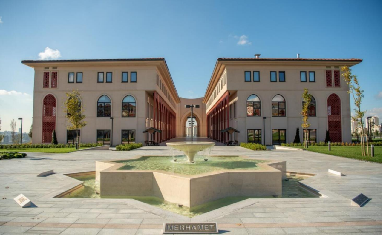
Giriş Binaları (Sağda gözüken bina Kütüphane olarak hizmet vermektedir)
